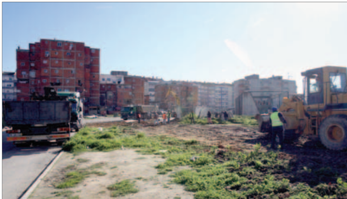
Bairro da Jamaica é composto por vários prédios inacabados e continua a crescer com novas construções
